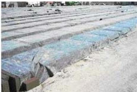
Figura 6. Protección de los tabicones para evitar la pérdida de agua por evaporación
