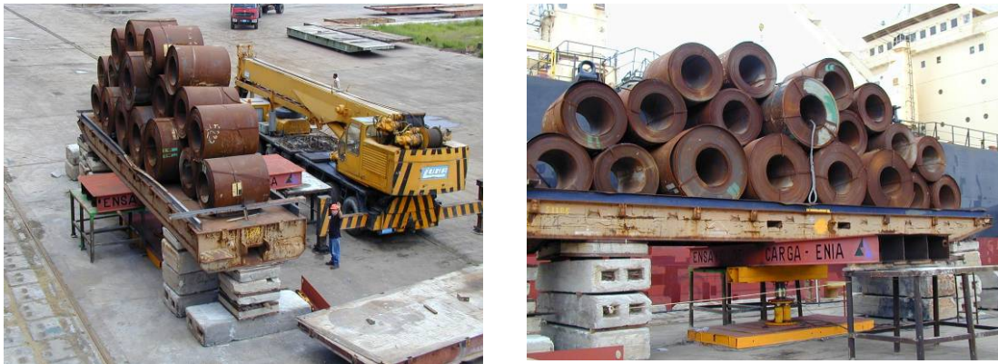
Figura 6. Prueba de carga “in situ”.
