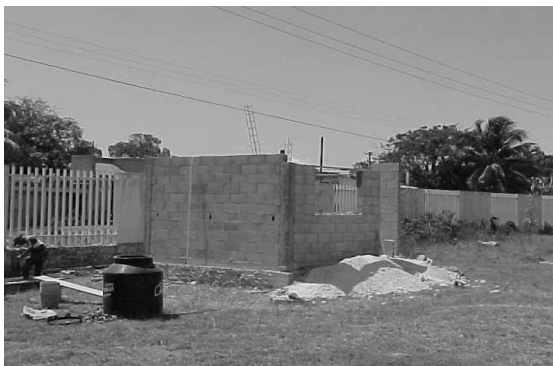
Figura 8. Muros, dalas y castillos.
