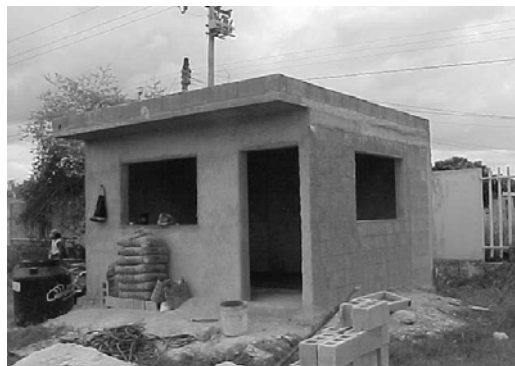
Figura 9. Cubierta y acabados
