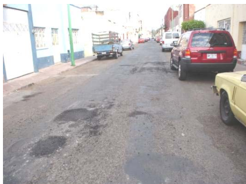
Figura 3. Bacheo, como intervención mínima en mantenimiento vial
