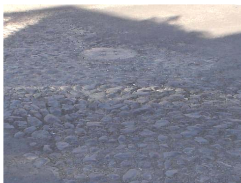
Figura 7. Carpeta asfáltica sobre vialidad empedrada
