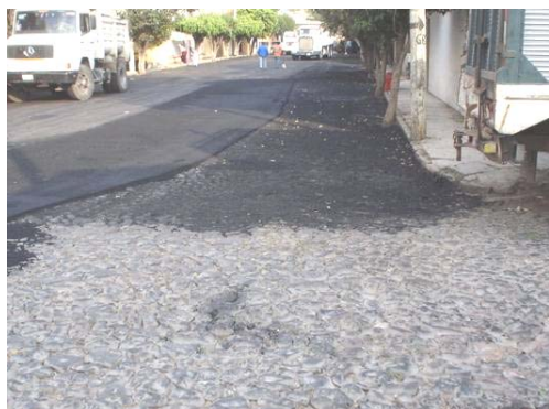
Figura 6. Trabajos de colocación de carpeta asfáltica sobre vialidad empedrada
