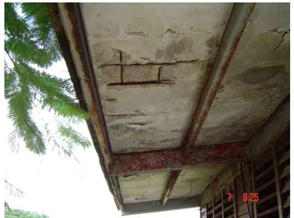
Figura 6. Estructura tipo C
