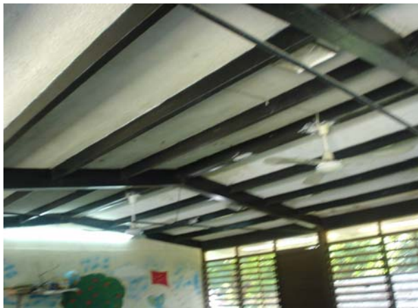
Figura 5. Estructura tipo C
