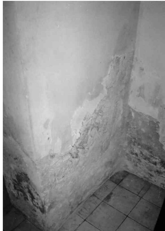
**Figura 4. Daños en muro por ascensión de la humedad.**
