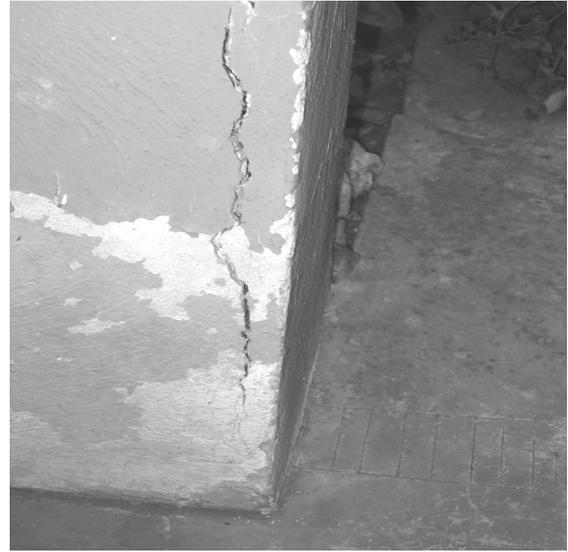
**Figura 1. Agrietamiento por corrosión de acero de refuerzo en columna.**
