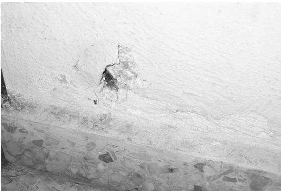
**Figura 5. Daño en cadena de cimentación por corrosión.**
