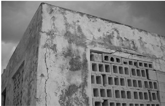
**Figura 3. Condiciones inseguras causadas por la corrosión del refuerzo.**
