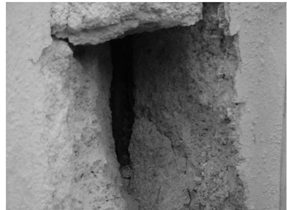
**Figura 7. Daño en castillo ahogado por corrosión inducida por carbonatación.**
