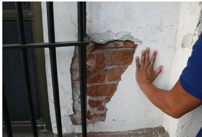
Figura 04. Muro de fachada principal del inmueble caso de estudio, donde se observa mampostería de ladrillo.
