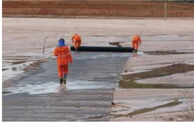
Figura 2. Instalación de geomallas en carretera.
