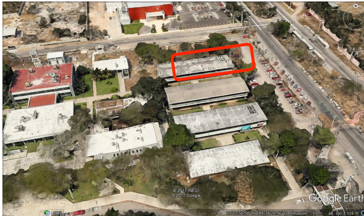
Figura 1. Ubicación geográfica del Edificio F.
