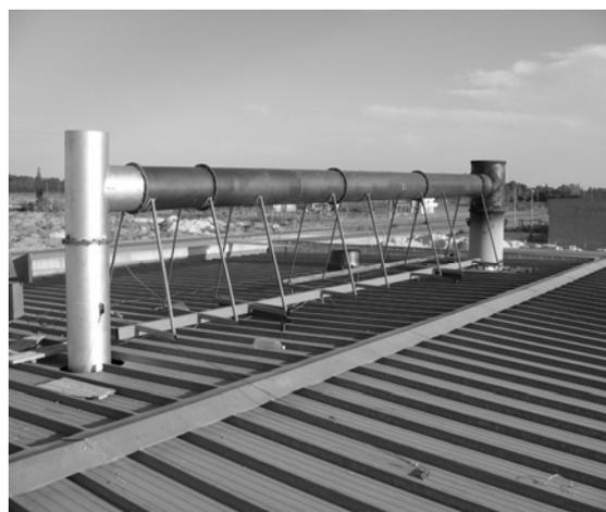
**Figura 2.** Enfriador instalado en el incinerador.
