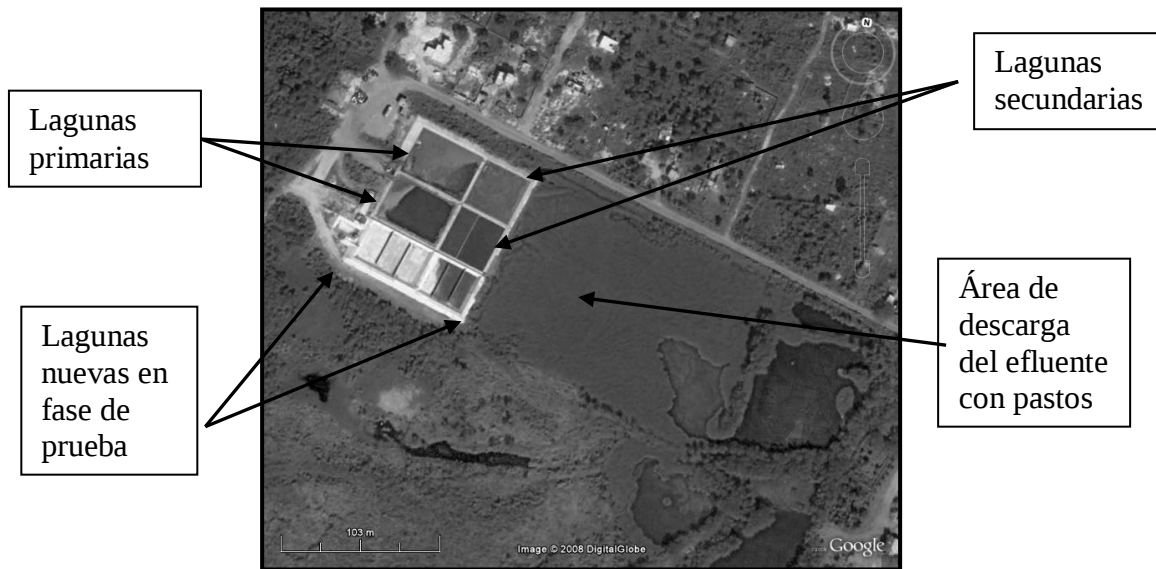
Figura 2. Vista aérea y definición de los dos sistemas de lagunas de oxidación de la ciudad de Mérida, Yucatán.
